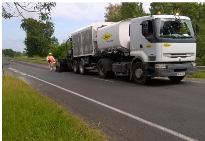
Chantier Colmat® en couche d'accrochage
